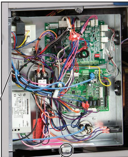
La fixation de mise en terre doit être installée pour assurer la mise en terre adéquate de l'unité.
